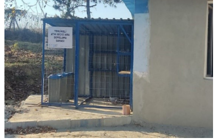
Malkara İlçesi TESKİ Gönence İçme Suyu Terfi Merkezi Tehlikeli Atık Geçici Ara Depolama Sahası
