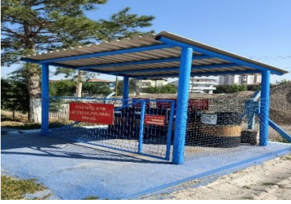
Muratlı İlçesi TESKİ İçme Suyu Terfi Merkezi Atık Depolama Sahası
