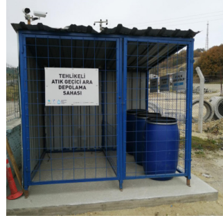
Çerkezköy İlçesi TESKİ İçme Suyu Terfi Merkezi Tehlikeli Atık Geçici Ara Depolama Sahası
