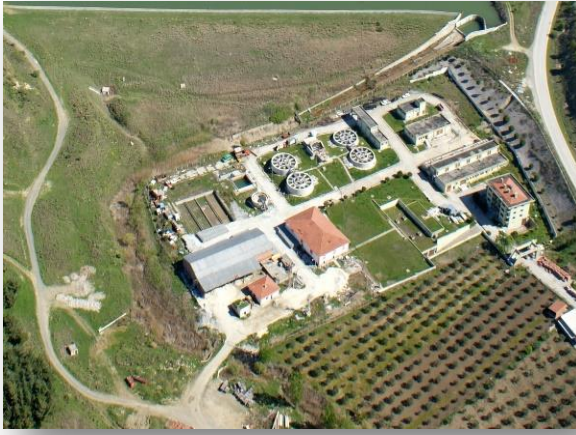
Şarköy İçme Suyu Arıtma Tesisi Genel Görünüm
