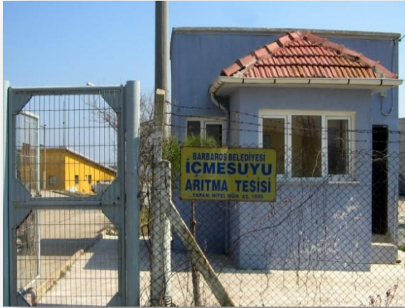
Barbaros İçme Suyu Arıtma Tesisi
