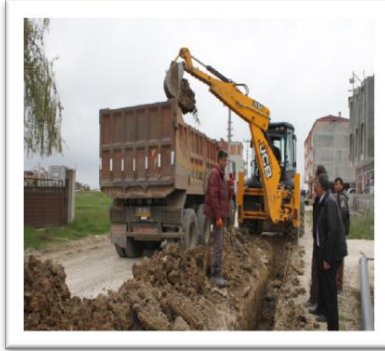
Kapaklı İlçesi İçme Suyu Şebeke Hattı Yapımı
