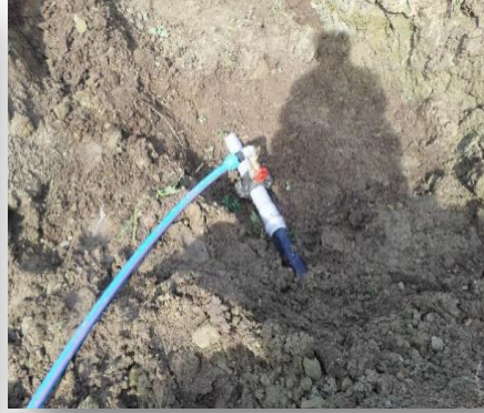
Ergene İlçesi, Marmaracık Mahallesi İçme Suyu Abone Bağlantısı
