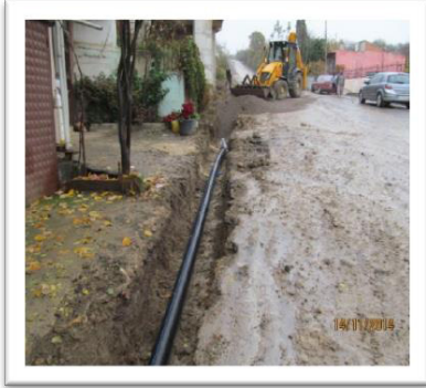
Süleymanpaşa İlçesi İçme Suyu Şebeke Hattı Yapımı
