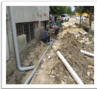
Saray İlçesi Çukuryurt Mahallesi Kanalizasyon Şebeke Hattı Yapımı
