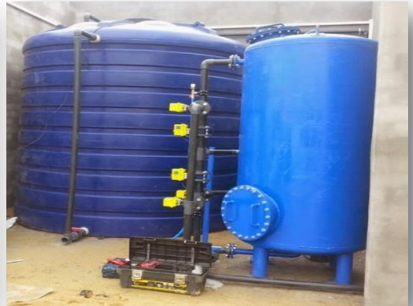
Hayrabolu Dambaslar İçme Suyu Arıtma Tesisi Paket Arıtma Sistemi
