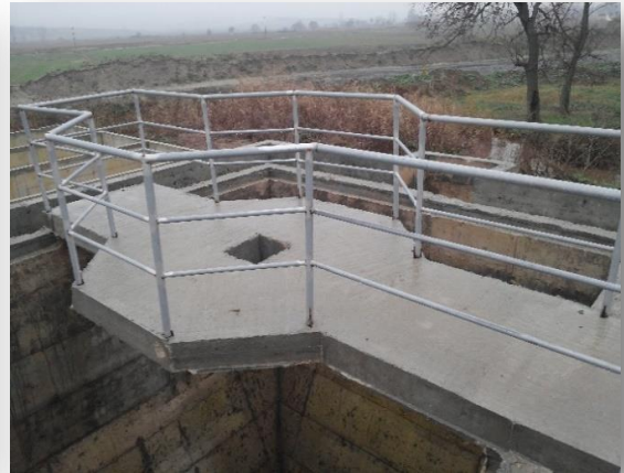
Şalgamlı Atıksu Arıtma Tesisi
