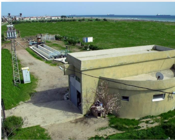
Şarköy Derin Deniz Deşarjı Uzaktan Görünüm
