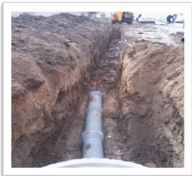
Çerkezköy İlçesi Kanalizasyon Şebeke Hattı Yapımı
