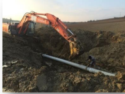
Süleymanpaşa İlçesi İçme Suyu Arıza Çalışmaları
