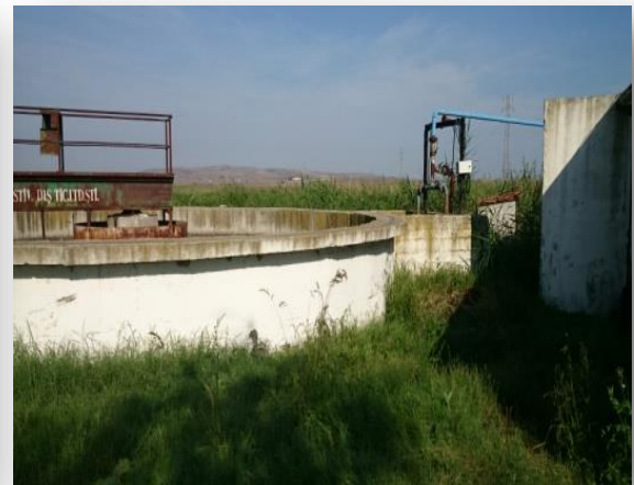
Çamur Yoğunlaştırma Havuzu
