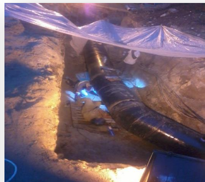
Çerkezköy İlçesinde Ø800 mm çapında içme suyu borusu dere altından geçiri- lerek bağlantıları yapılmış ve su akışını engelleyen eski boru yerinden kaldırılmış- tır.
