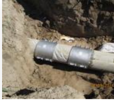
Marmaraereğlisi İlçesi İçme Suyu Arıza Çalışmaları
