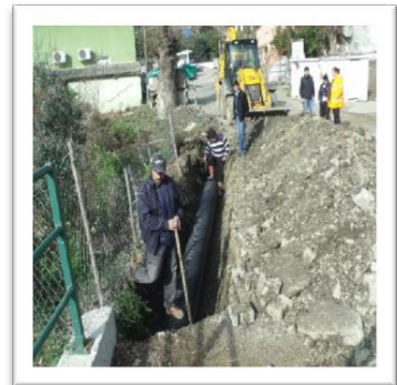
Şarköy İlçesi, Uçmakdere Mahallesi Yağmursuyu Şebeke Hattı Yapımı
