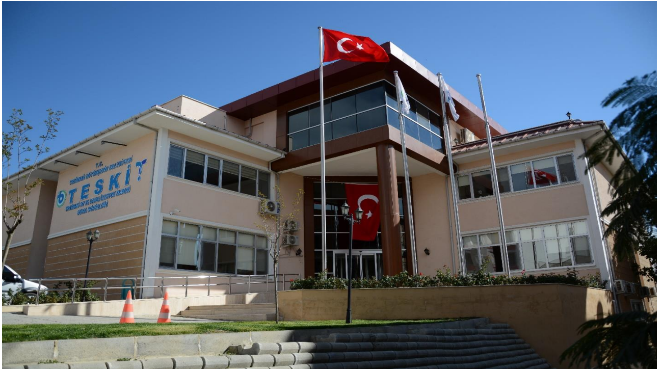
Resim 1: TESKİ Genel Müdürlük Binası
