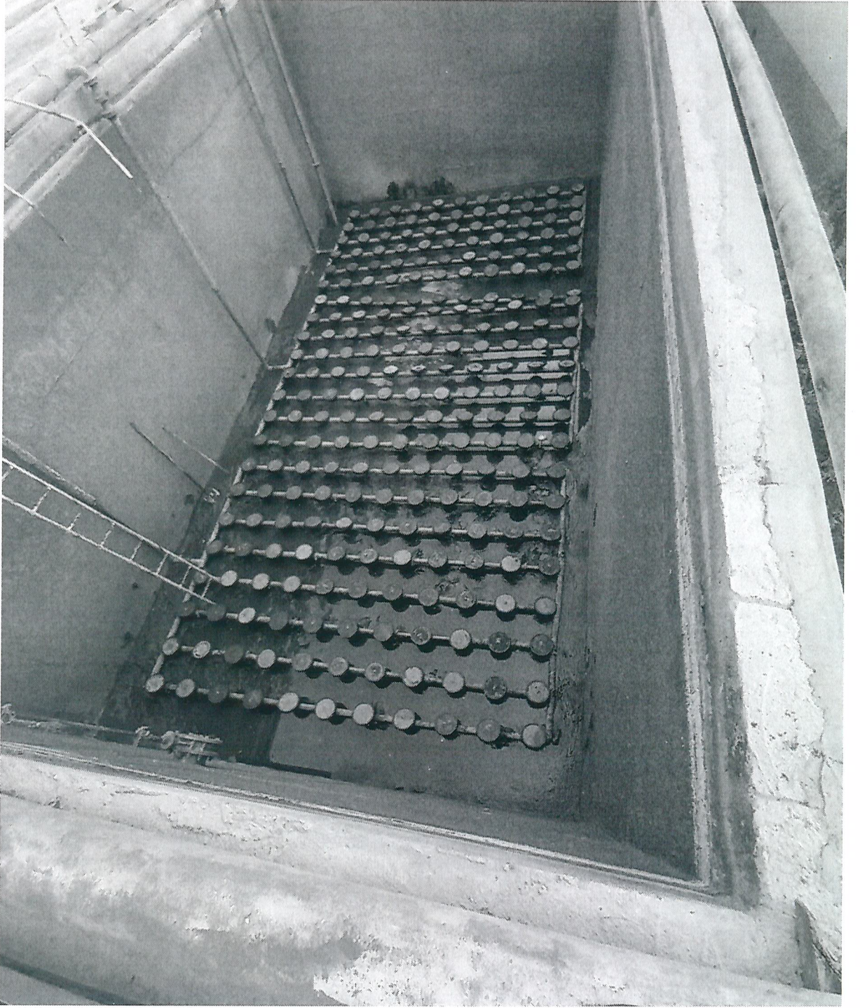
Görsel 2: Havalandırma Havuzu, demontajı yapılacak mevcut difüzör tarlası görseli.
