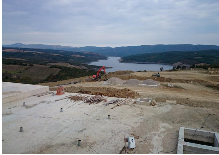
Şekil 3. Yapımı Devam Eden Çokal Barajı İnşaatı
