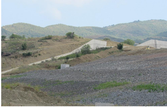
Şekil 4. Yapımı Devam Eden Naipköy Barajı İnşaatı
