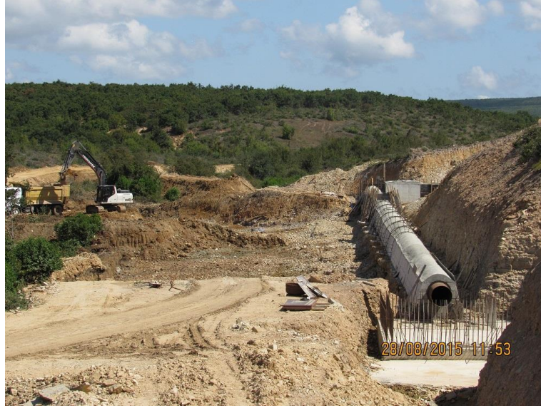
Şekil 2. Yapımı Devam Eden Saray Ayvacık Göleti İnşaatı
