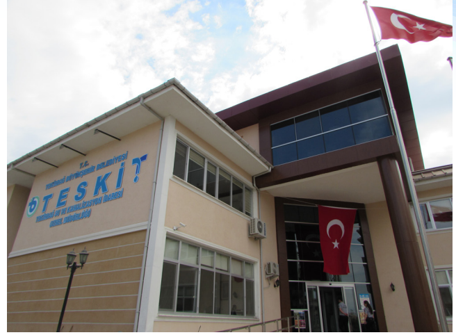
TESKİ Genel Müdürlüğü Ana Hizmet Binası
