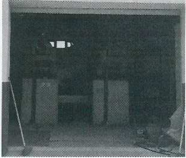
Malkara İBAAT Dekantör binası (1 kapı)
