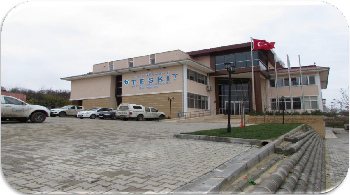
Resim 1: TESKİ Genel Müdürlük Binası
