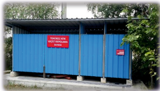
Tehlikeli Atık Geçici Depolama Alanı
