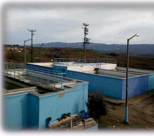
Çöktürme Havuzu ve Kum Filtreler
