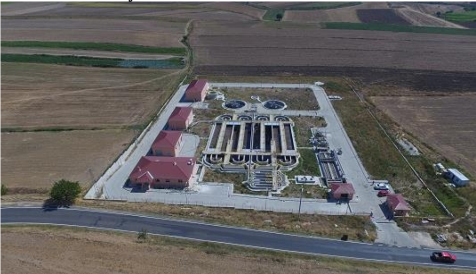
Hayrabolu Atıksu Arıtma Tesis
