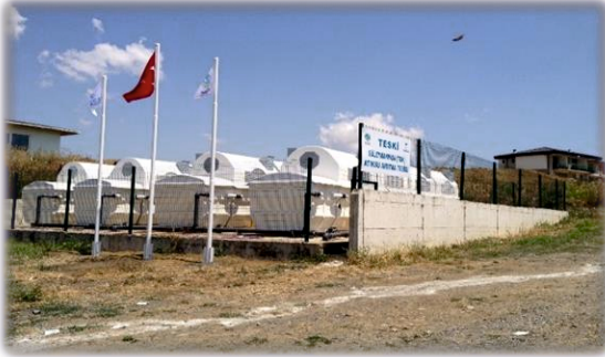
Tesis Genel Görünüşü
