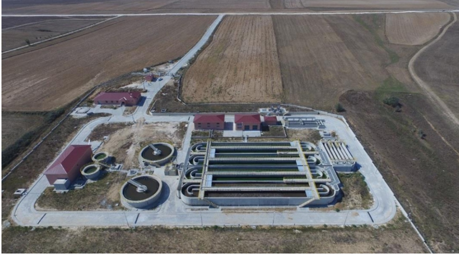
Saray Atıksu Arıtma Tesisii
