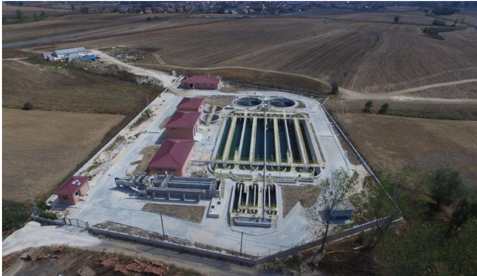
Muratlı Atıksu Arıtma Tesisii
