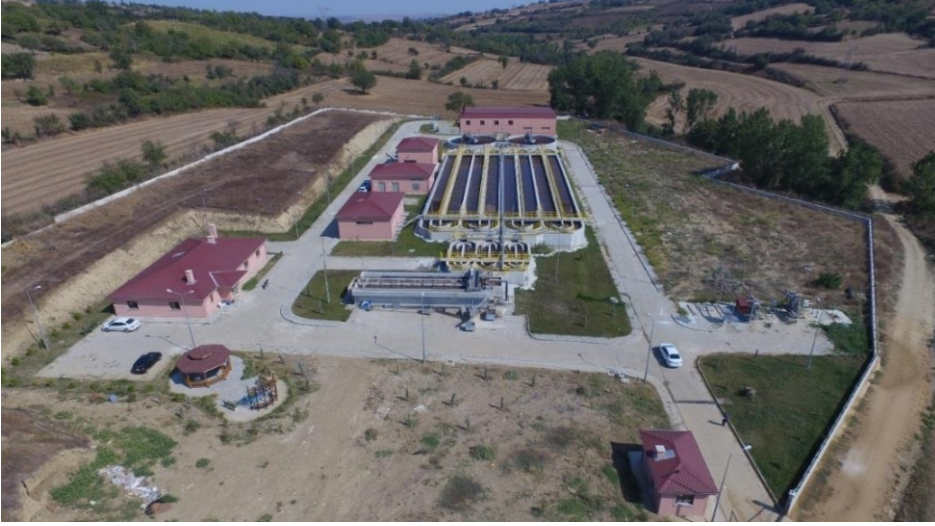
Malkara Atıksu Arıtma Tesis
