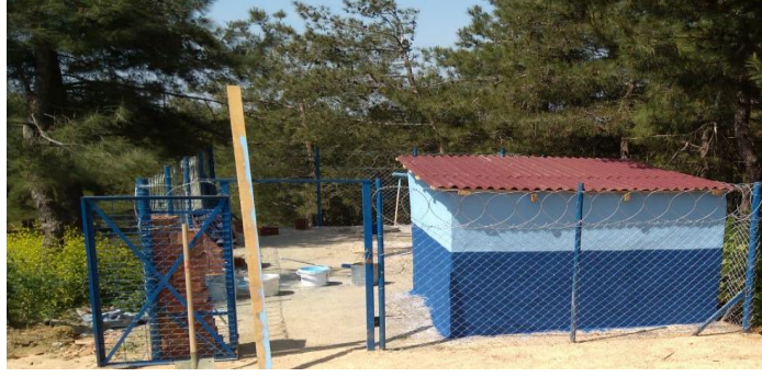
Malkara Huzur sokak Atıksu Terfi Merkezi TM 4
