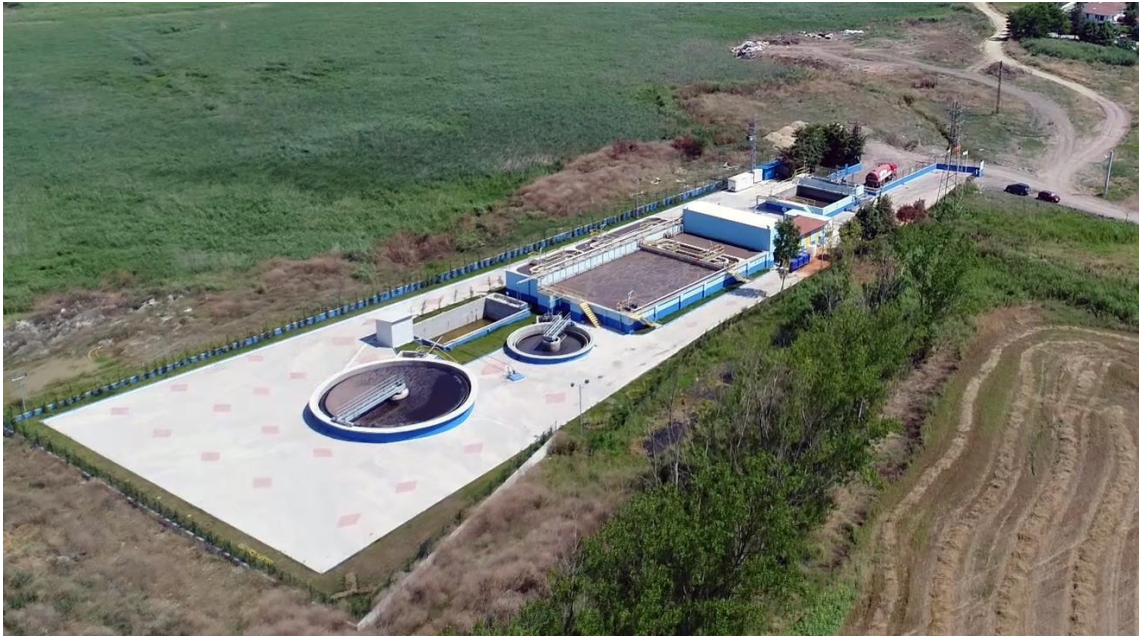
Tesisin Genel Görünümü
