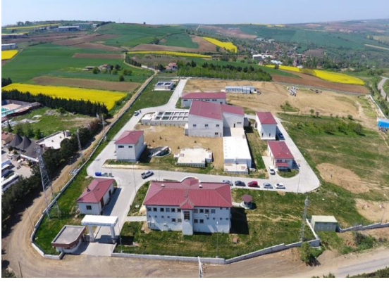
Tekirdağ (Naip) İçme Suyu Arıtma Tesisi
