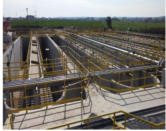
Muratlı Atıksu Arıtma Tesisi
