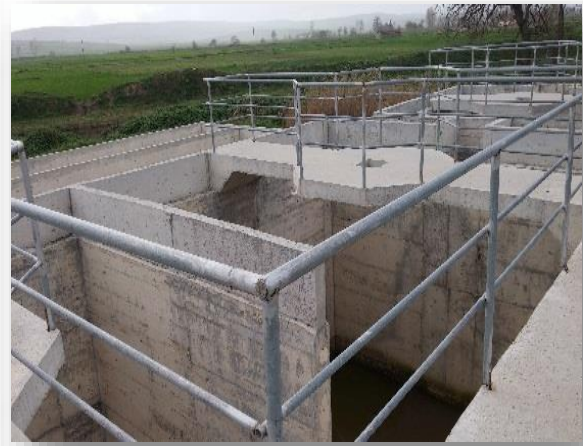
Şalgamlı Atıksu Arıtma Tesisi
