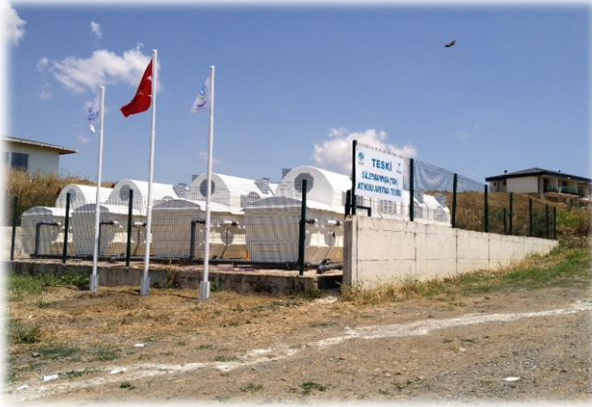
Tesisin Dış Görünümü
