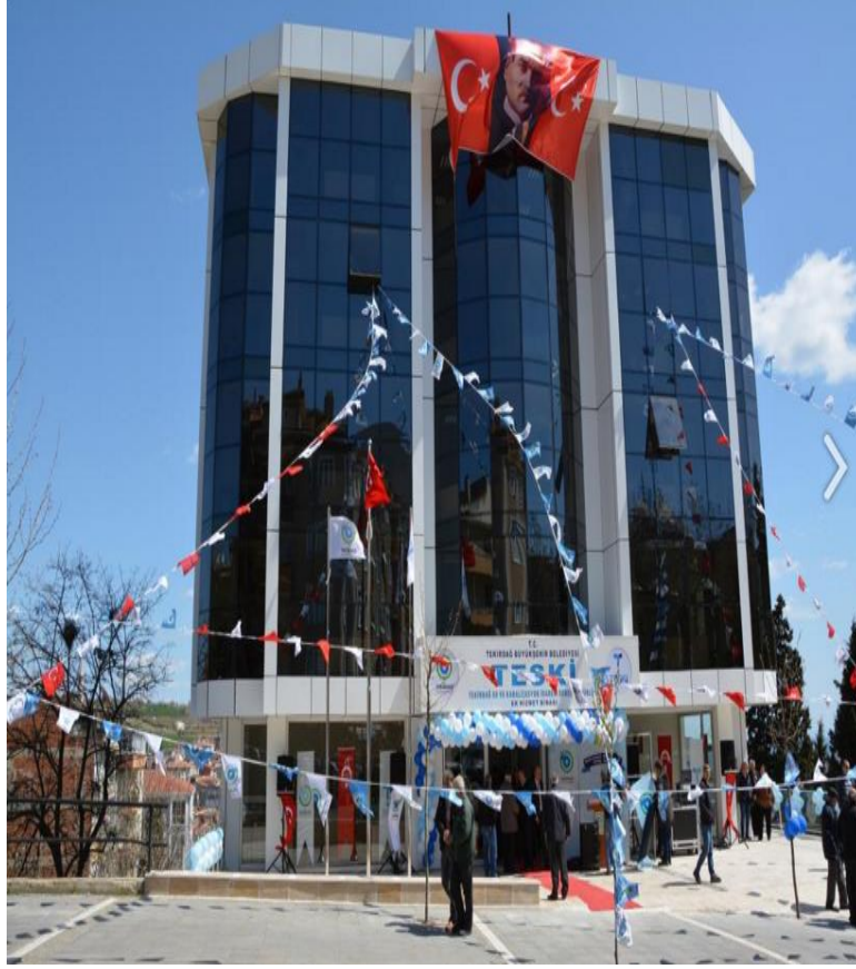
TESKİ Ek Hizmet Binası
