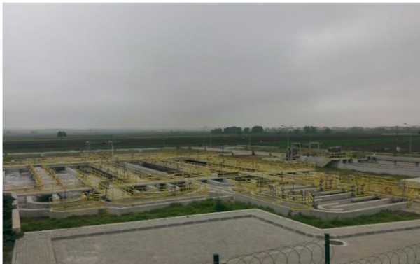
Hayrabolu Atıksu Arıtma Tesisi
