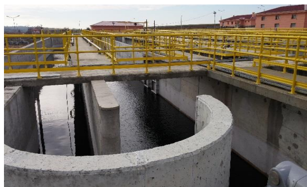
Saray Atıksu Arıtma Tesisi
