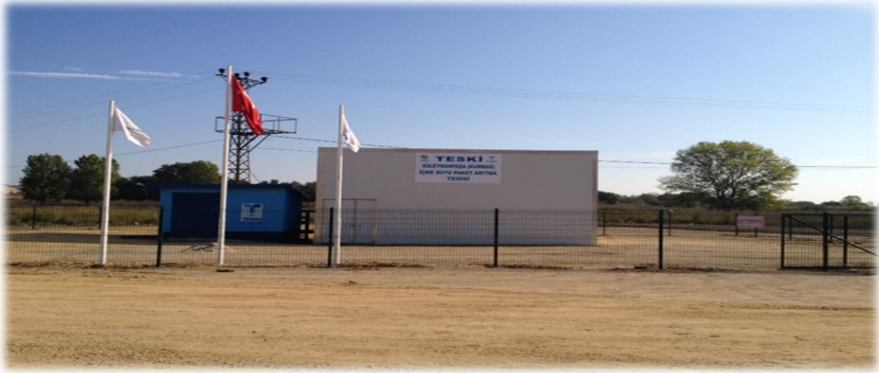
Tesisin Dış Görünümü
