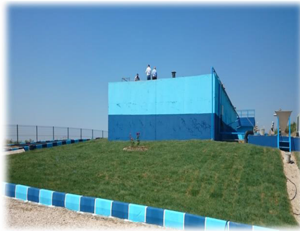
Tesisin Dış Görünümü
