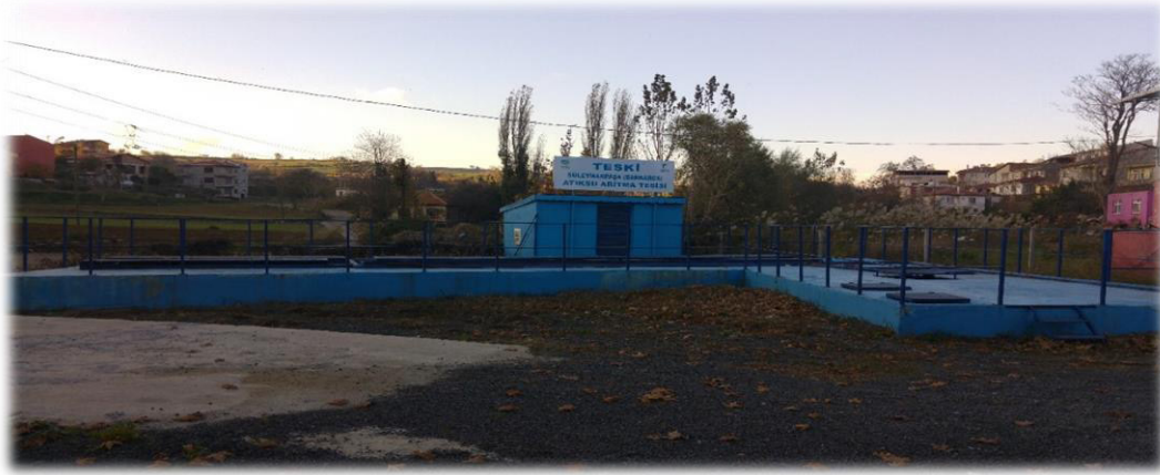
Tesisin Dış Görünümü
