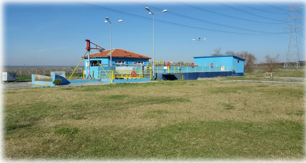
Tesisin Genel Görünümü
