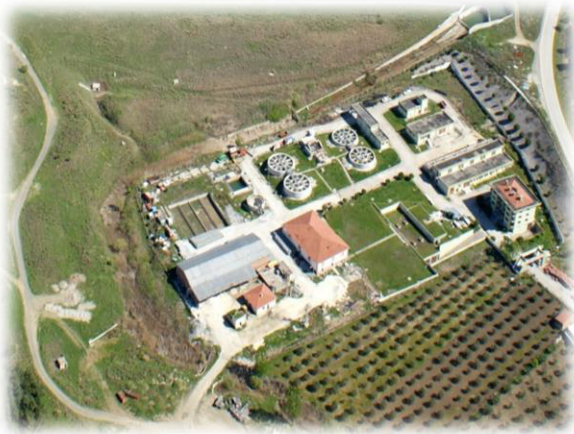
Tesisin Genel Görünümü
