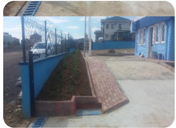
Süleymanpaşa İlçesi 5000 m 3 'lük İçme Suyu Deposu
