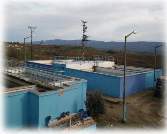
Çöktürme Havuzu ve Kum Filtreler
