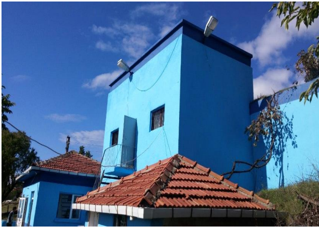
Malkara İlçesi 1500 m 3 'lük İçme Suyu Deposu
