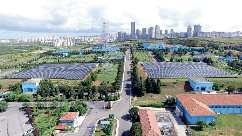
Şekil 18. İSKİ İleri Biyolojik Atıksu Arıtma Tesisinde GES ve Enerji Üretimi
