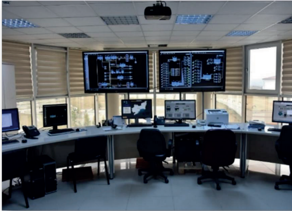
Şekil 12. TESKİ SCADA Sistemi
