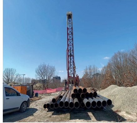
Şekil 7. Su Sondaj Kuyu Açım Çalışmaları
