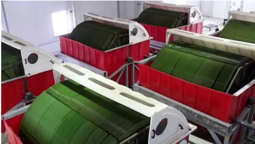
Yeşilsirt Atıksu Arıtma Tesisi
