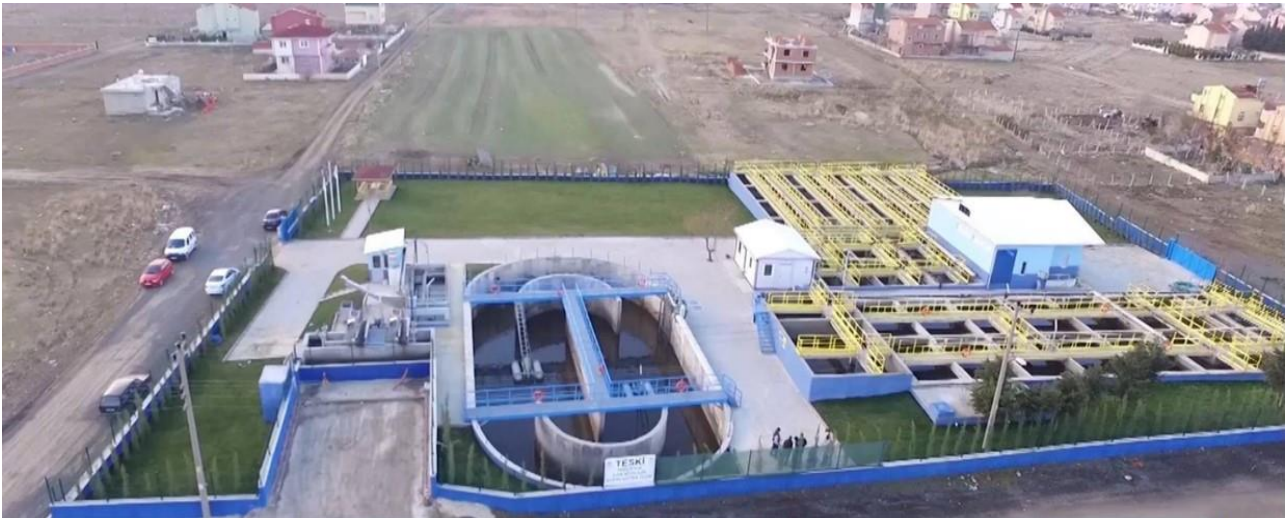
Yeniçiftlik İleri Biyolojik Atıksu Arıtma Tesisi
