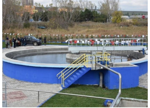
Yeni Yapılan Çöktürme Havuzu
