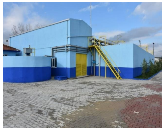
Çamur Yoğunlaştırma ve Ekipman Odası
