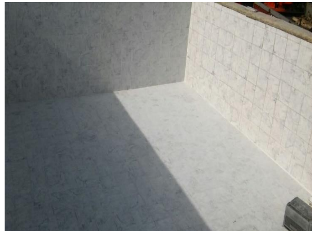
Yavaş Kum Filtre Havuzlarının Temiz Su Havuzuna Dönüştürme Hali
