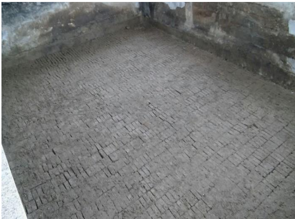
Yavaş Kum Filtre Havuzları Revizyon Öncesi
