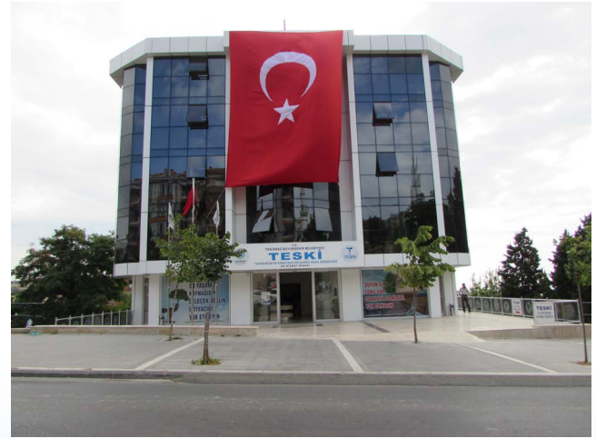
TESKİ Genel Müdürlüğü Ek Hizmet Binası
