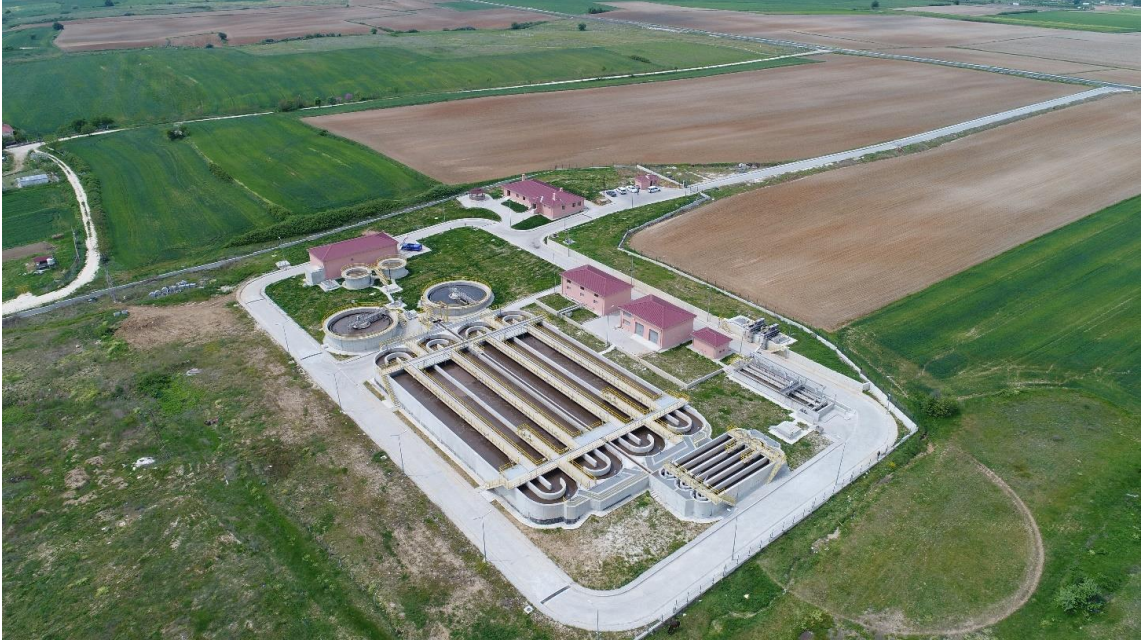
Tesisin Genel Görünümü
