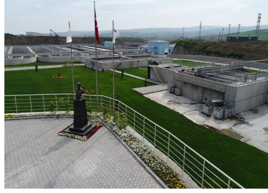
Süleymanpaşa Batı İleri Biyolojik Atıksu Arıtma Tesisi
