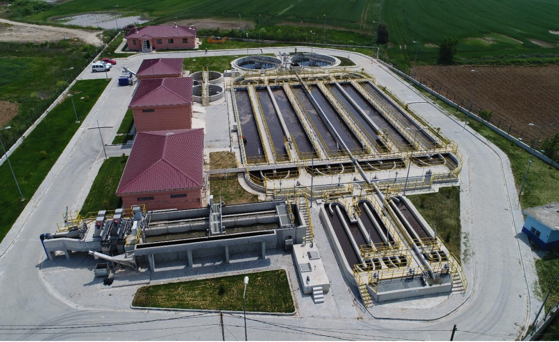
Tesisin Genel Görünümü
