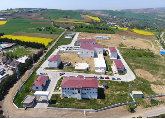
Tekirdağ (Naip) İçme Suyu Arıtma Tesisi
