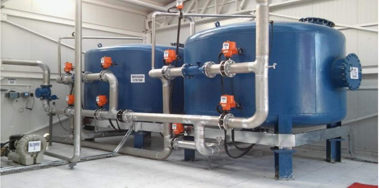
Kum Filtre ve Demir-Mangan Giderim Tankları
