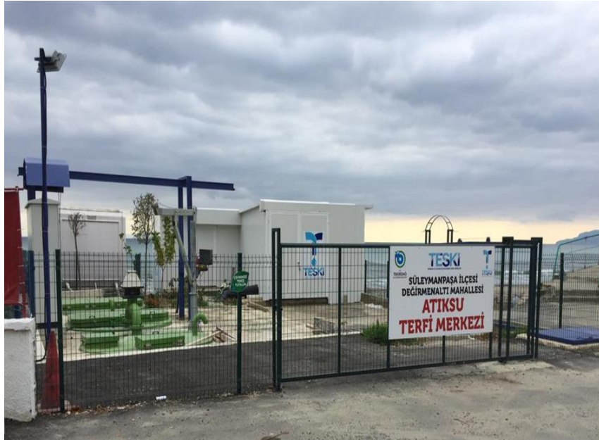
Değirmenaltı Mahallesi Atıksu Terfi Merkezi
