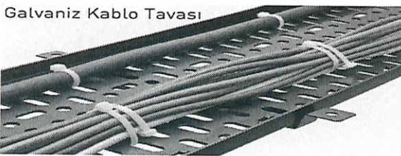
Galvaniz tavalı örnek kablo montajı
